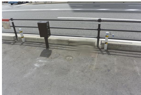
水道栓、電気ボックス、汚水ます(長浜エリア)
