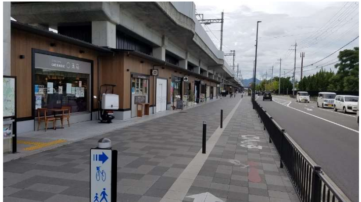
高架下東側の舗道
