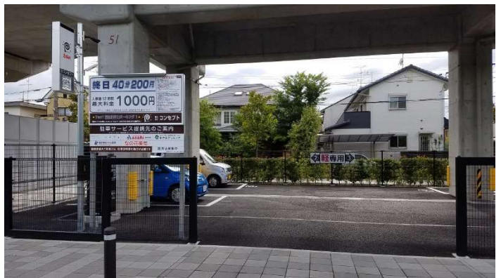
高架下の駐車場
