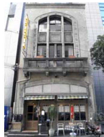
カフェ・レストランとなった旧今橋消防署 (出典：筆者撮影)
